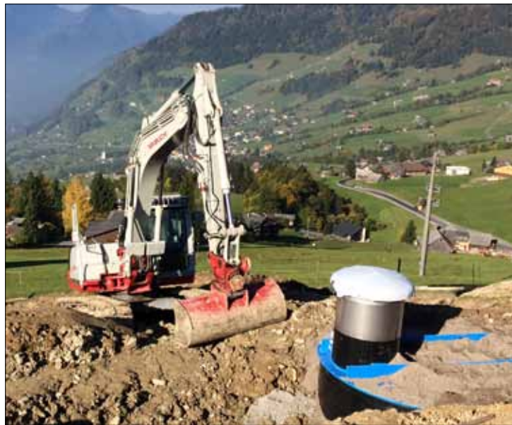
Im Unterschoss (hier im Bild) und im Tschervald wurden die Druckbrecher ersetzt. Bild: rr
